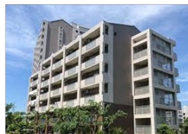
地方自治体への 公営住宅開放呼びかけ
